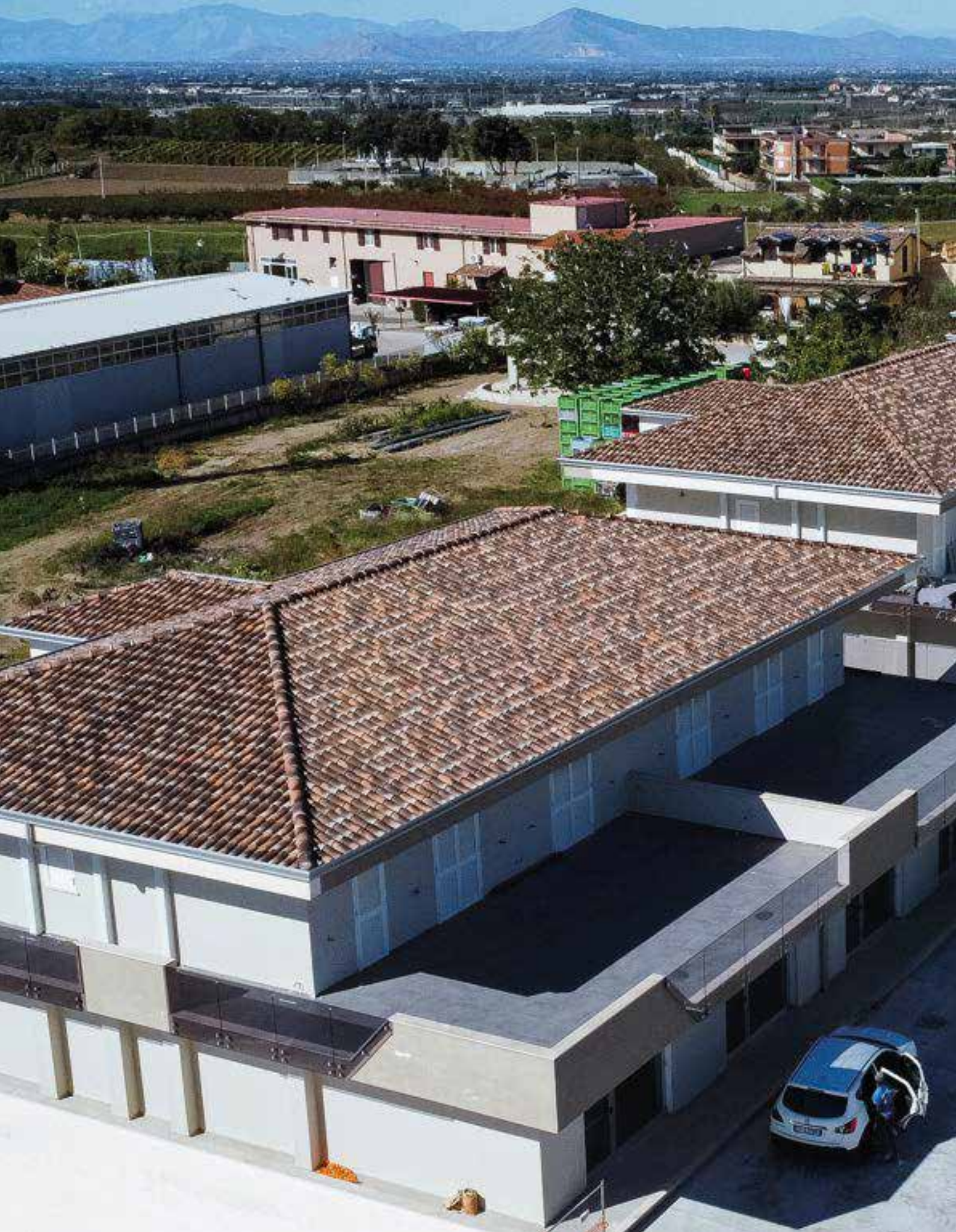
Realizzazione residenze e locale annesso – Marano di Napoli (NA)
